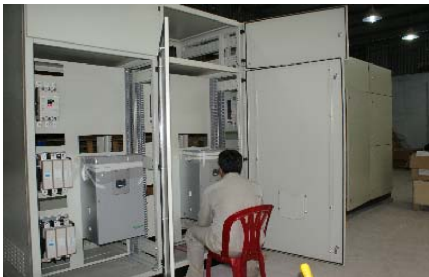
Hình ảnh: Hệ thống SCADA
